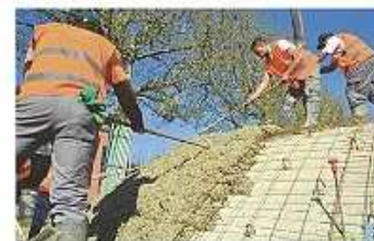
1. LE BÉTON, dont la formulation lui permet de ne pas couler sur les flancs des baleines, a été acheminé par des flexibles fixés sur une fiche articulée. 2. LES GRANULATS BLEUS sont installés sur les flancs des cétacés en commençant par le sommet de la sculpture. 3. LES 140 PANNEAUX DE L'ARMATURE en treillis soudés sont fixés dans la forme par des tiges de fer. 4. LES FLANCS DES DEUX BALEINES, dont la hauteur ne dépasse pas 1,50 m, s'établent en pente douce et laissent libre cours à l'imagination des enfants.
