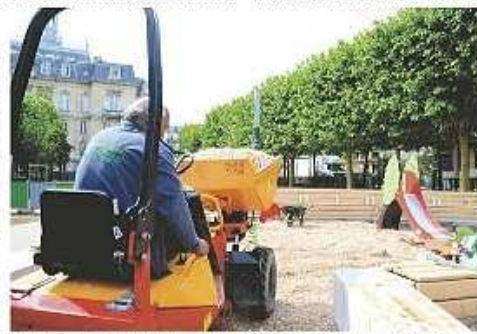
UN MATELAS DE COPEAUX DE BOIS DE 40 CM D'ÉPAISSEUR est installé au sol, autour des deux grandes baleines.
